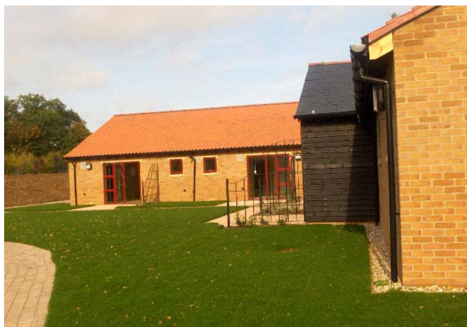
Billede 5: Udsigt over New Farleigh Hospice sengeafsnit (under opførelse)
